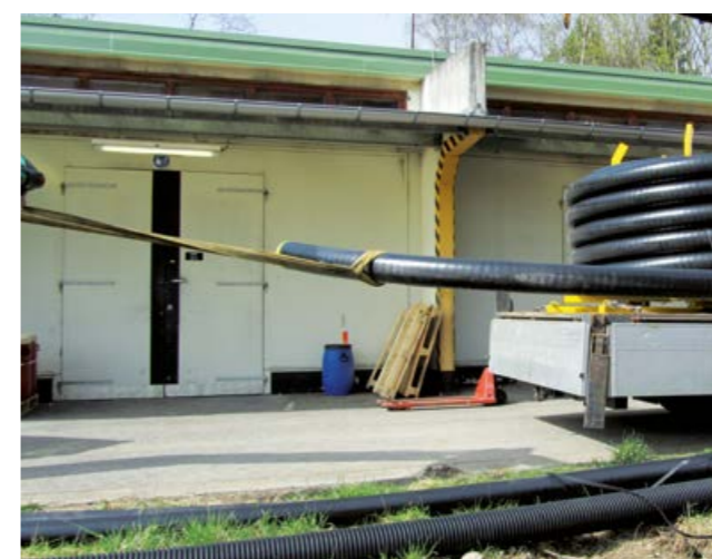
⑭ Mit Gurten befestigter Anfang der PEX-Rolle
