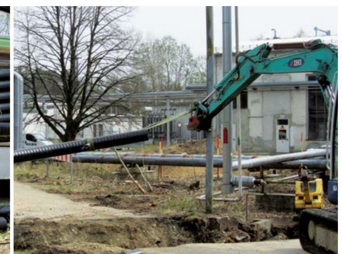
⑮ Abfahren der Rohrtrasse
