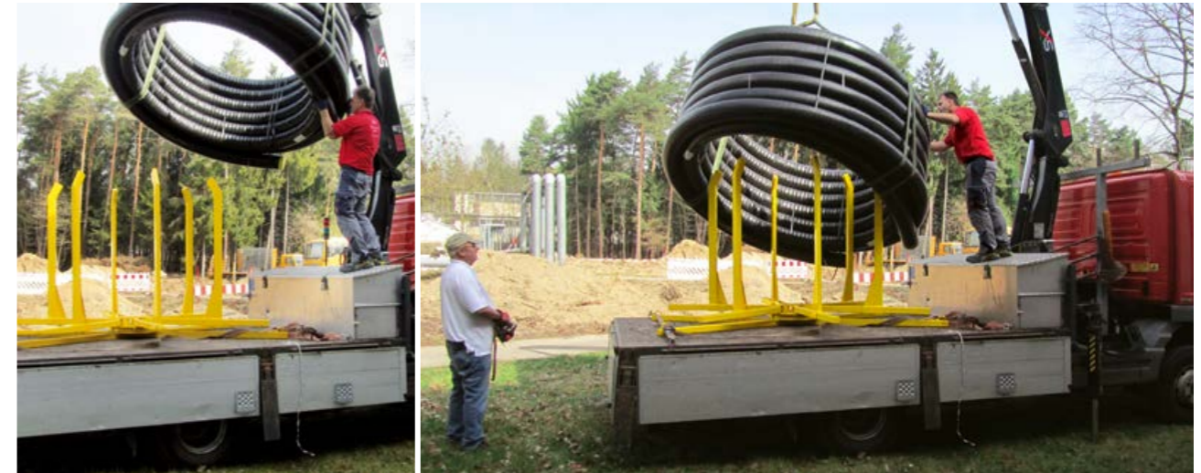
⑪ + ⑫ Ablassen der isopex-Rolle
