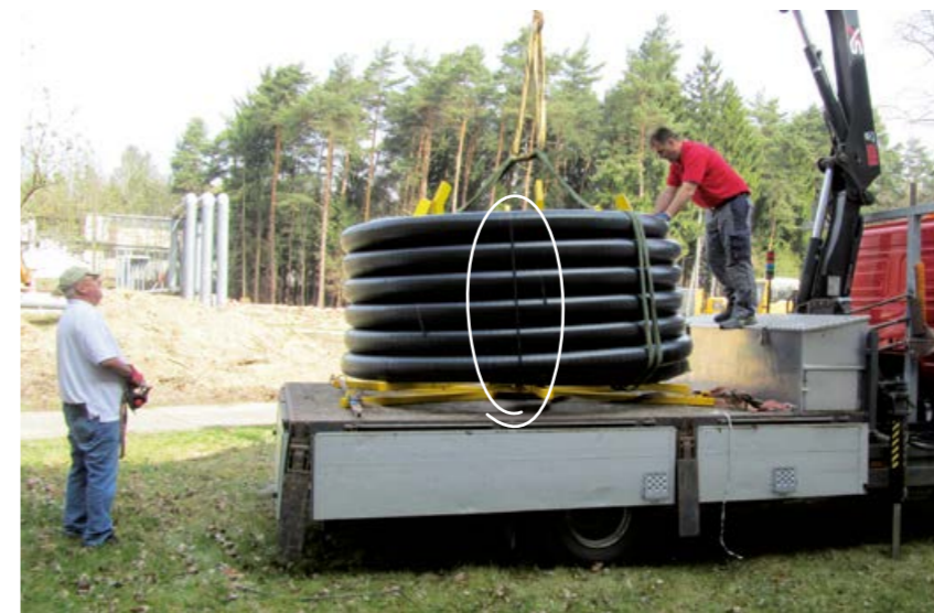
⑬ Sicherungs- bzw. Transportbänder sind ungeöffnet beim Herablassen auf die Abrollspinne!
