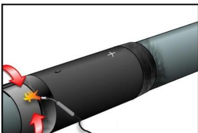
Schrumpfvorgang mit weicher Flamme gleichmäßig in kreisenden Bewegungen auf der Muffenseite beginnen und in Richtung Mantelrohrseite fortsetzen.
